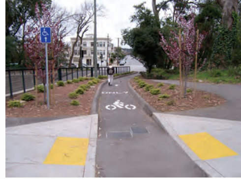
الشكل ب: أسطح تحذيرية قابلة للكشف. مثال على سطح التحذير القابل للكشف والمستخدم عند معبر المشاة وتداخلات مسارات حركة الدراجات.
