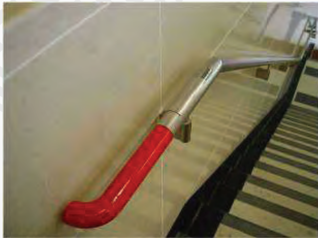
شكل ٦٨: امتدادات الدرابزين. مثال لدرج مميز بامتدادات درابزين ذات لون مغاير.
