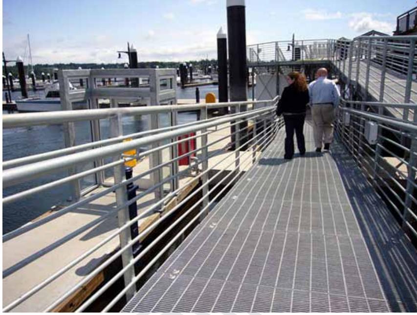
شكل رقم ٦٣: الوصول للمراسي والممرات الخشبية والمزالق بالمنحدرات. - لاحظ أن متطلبات المنحدرات يمكن تطبيقها بسهولة في هذه الظروف الخاصة.
